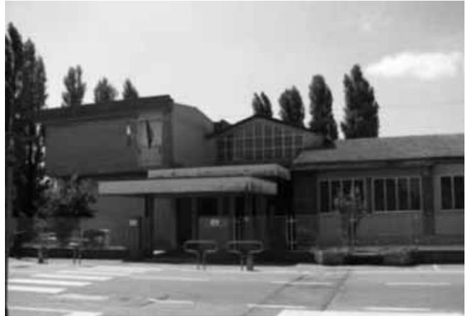
Figura 5 – La scuola media Galileo Galilei di Vigarano Mainarda (FE), danneggiata dal sisma dell'Emilia del 20 maggio 2012 e successivamente messa in sicurezza mediante l'inserimento di tiranti, ma, nonostante ciò, risultata ancora caratterizzata da un'elevata vulnerabilità sismica, stando ai risultati dell'analisi di vulnerabilità commissionata dal comune (la scuola è poi stata sottoposta ad un intervento di rinforzo).
