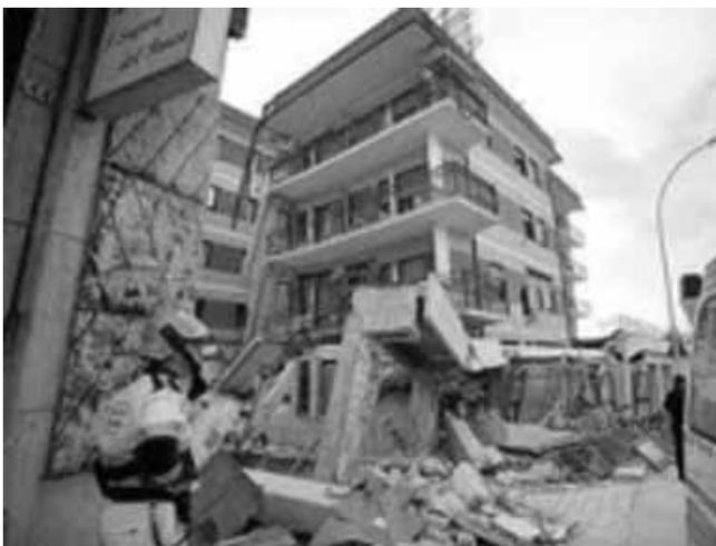
Figura 3 – Collasso della “Casa dello Studente” a L’Aquila durante il terremoto dell’Abruzzo del 6 aprile 2009 ( $M = 6,2$ ).
