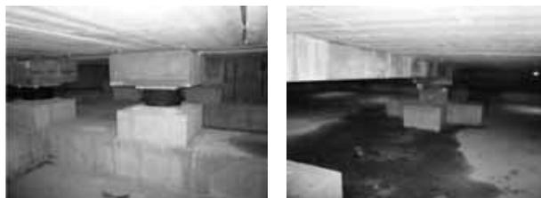
Figure 10 e 11 – Due dei 28 HDRB ed uno dei 14 SD che costituiscono il sistema di isolamento sismico della nuova scuola di Marzabotto di Figura 9.
