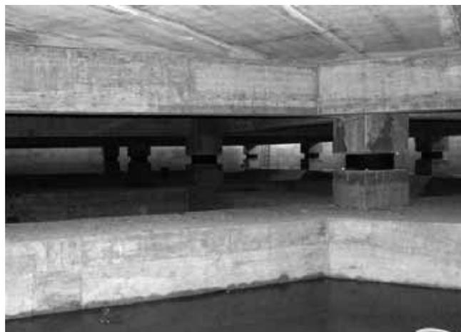
Figura 8 – Alcuni dei 61 isolatori elastomerici ad alto smorzamento (*High Damping Rubber Bearing* o HDRB) e dei 12 isolatori a scorrimento a superficie piana acciaio-Teflon (*Sliding Device* o SD) che costituiscono il sistema di isolamento sismico del complesso di San Giuliano di Puglia di Figura 7.
