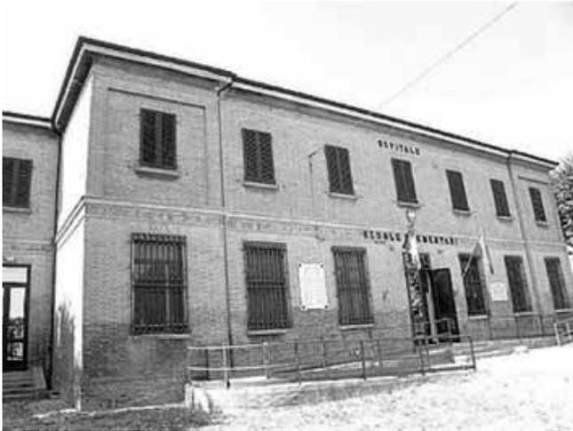
Figura 4 – La scuola elementare F. Filzi di Ospitale di Bondeno, costruita nel 1925 (in mattoni pieni e malta di calce) ed oggetto di ristrutturazione del tetto negli anni Settanta, all'indomani del terremoto in Emilia del 20 maggio 2012.
