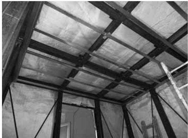
Fase di montaggio del controsoffitto in cartongesso, a scheletro portante ultimato
