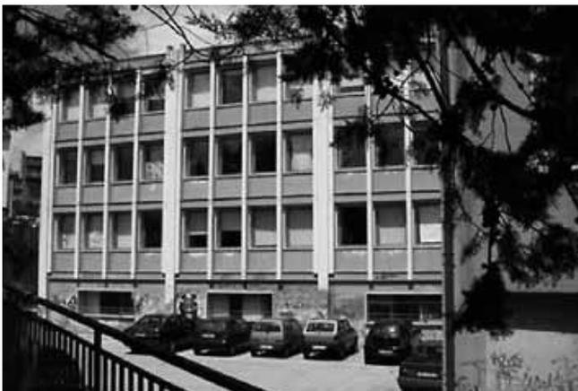
Figura 6 – Il Liceo Scientifico Romita di Campobasso nel 2003 (quando ospitava 1300 studenti), prima delle iniziali inutili opere di rinforzo e della successiva demolizione (effettuata solo nel 2009, a seguito del terremoto in Abruzzo) dei due corpi di fabbrica che erano risultati maggiormente insicuri, per la pessima qualità dei materiali costruttivi (evidenziata dai risultati di prove effettuate dall'ENEA dopo il sisma del Molise e della Puglia del 31 ottobre 2002).
