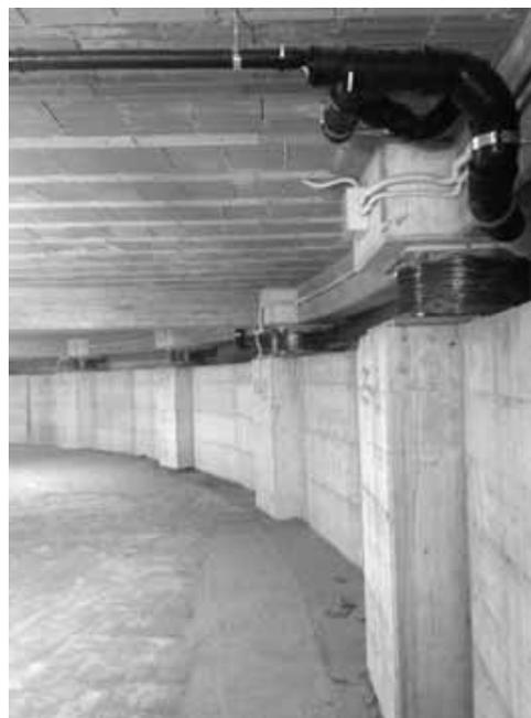
Figura 13 – Alcuni dei 29 isolatori in gomma-piombo (*Lead Rubber Bearing* o LRB) e dei 15 SD che costituiscono il sistema d'isolamento sismico della nuova scuola di Mulazzo di Figura 12.
