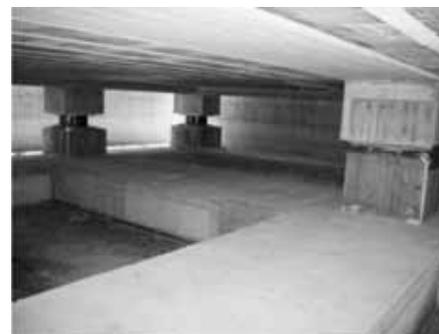
Figure 14 e 15 – Il nuovo blocco del Liceo Scientifico Romita di Campobasso di Figura 6, durante la ricostruzione con l’isolamento sismico, effettuata a seguito della demolizione del preesistente edificio (foto di novembre 2011); il certificato di collaudo in corso d’opera è stato rilasciato dallo scrivente, per conto dell’ENEA, in giugno 2013.
