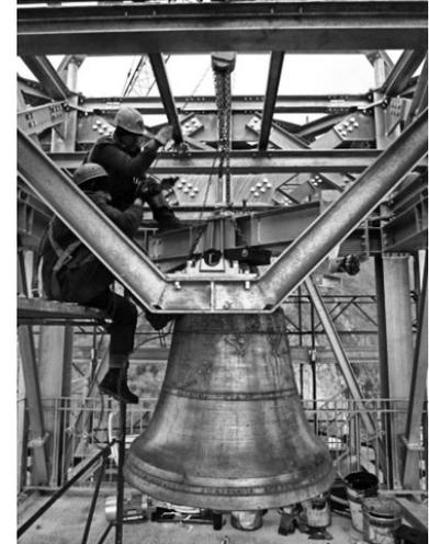
Figure 9-11 – La struttura in acciaio a tre livelli realizzata per la ricostruzione della "Torre dell'Orologio" del Castello di Gemona del Friuli, dotata di 22 dissipatori BRAD (foto fornite dal Geom. Iob).
